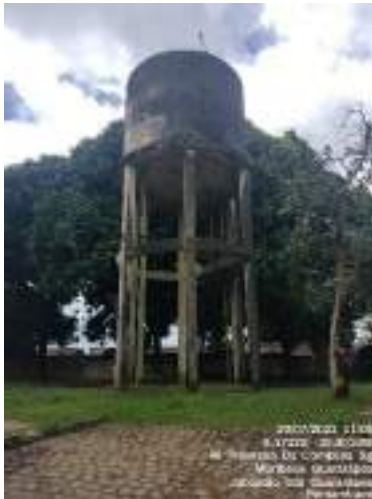
Figura 128: Reservatório elevado pertencente ao SAA de Jaboatão dos Guararapes
