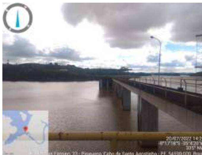
Figura 66: Torre de captação
