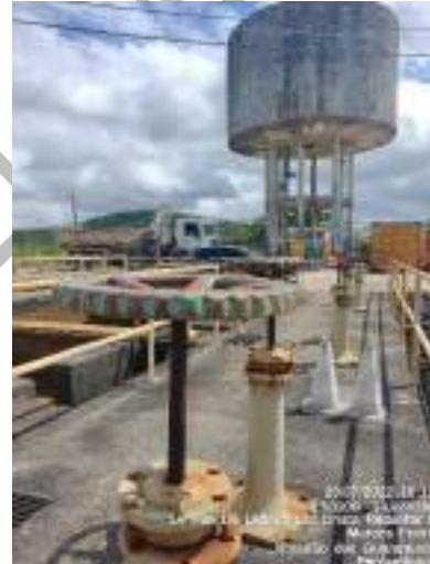
Figura 129: Reservatório elevado pertencente ao SAA de Jaboatão dos Guararapes
