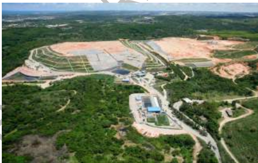
Figura 312: Vista aérea do Aterro Sanitário CTR Candeias
