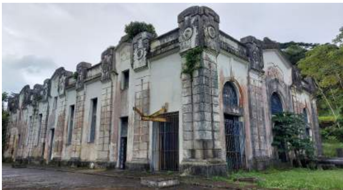
Figura 102: Casa de filtros localizada na ETA Gurjaú
