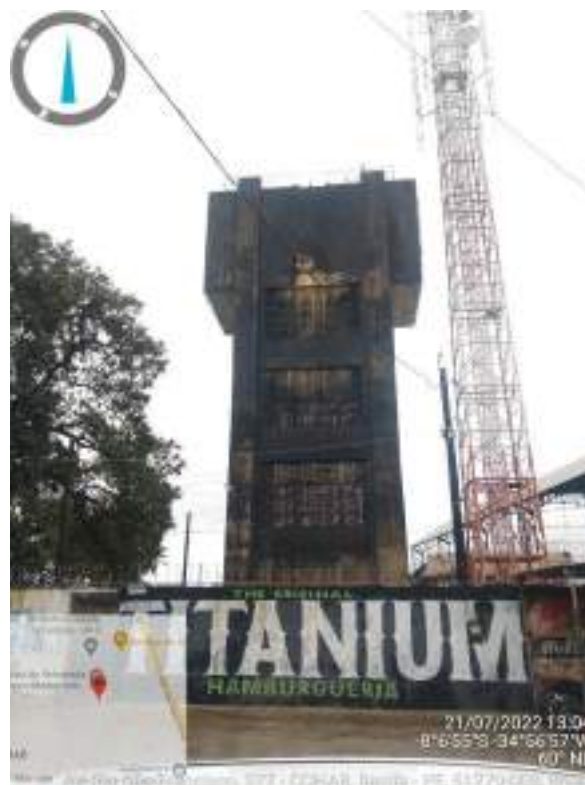
Figura 131: Reservatório elevado pertencente ao SAA de Jaboatão dos Guararapes
