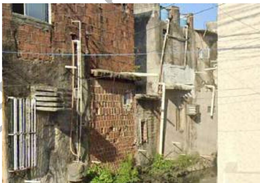
Figura 228: Detalhe das ligações clandestinas encontradas no Canal das Carolinas
