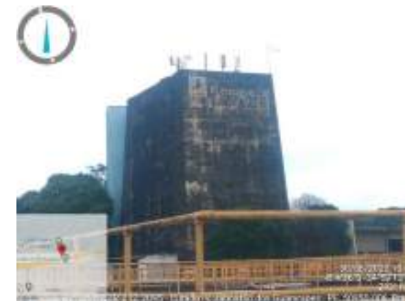
Figura 91: Reservatório da ETA Castelo Branco
