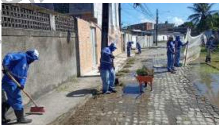
Figura 274: Varrição em ruas pavimentadas no município de Jaboatão dos Guararapes
