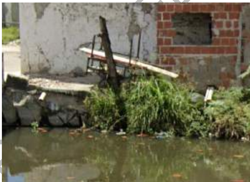
Figura 222: Detalhe das ligações clandestinas encontradas no Canal de Setúbal
