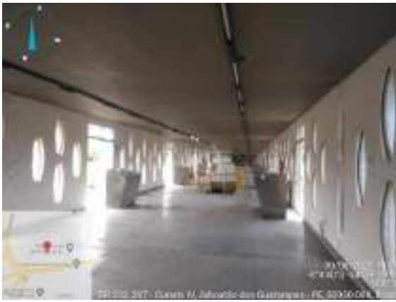
Figura 92: Instalações da ETA Castelo Branco
