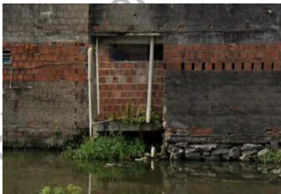
Figura 224: Detalhe das ligações clandestinas encontradas no Canal Aniceto Varejão
