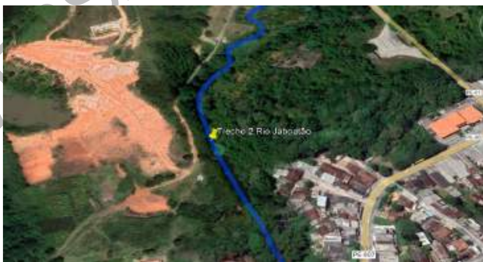
Figura 242: Encosta desprovida de cobertura vegetal próximo ao Rio Jaboatão
