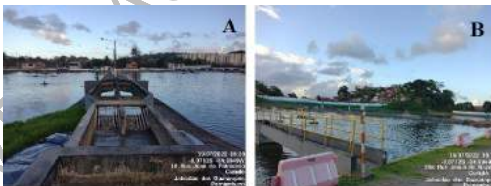
Figura 189: ETE Curado. A) tratamento preliminar B) lagoa de estabilização.
