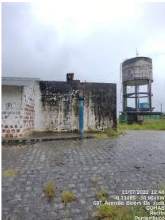
Figura 130: Reservatório elevado pertencente ao SAA de Jaboatão dos Guararapes
