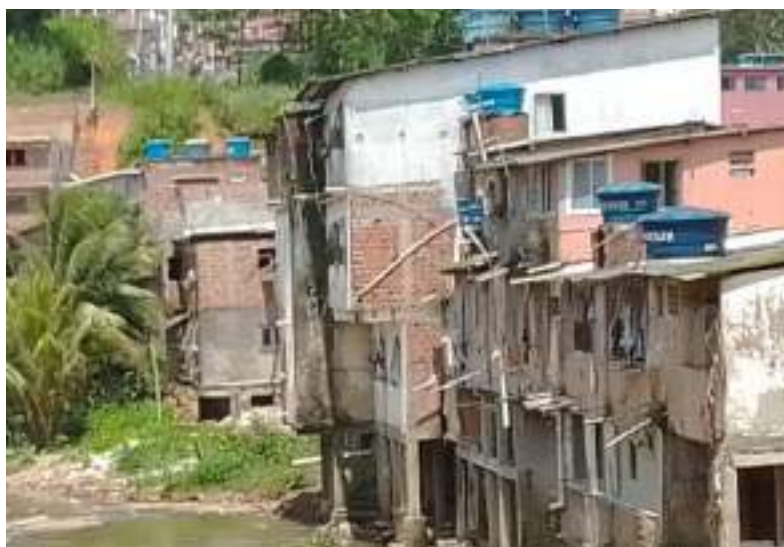
Figura 255: Detalhe das ligações clandestinas encontradas no Rio Duas Unas – Centro
