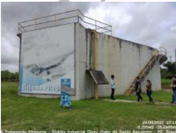
Figura 72: Torre de chegada de água bruta da ETA Pirapama
