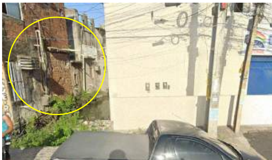
Figura 228: Detalhe das ligações clandestinas encontradas no Canal das Carolinas
