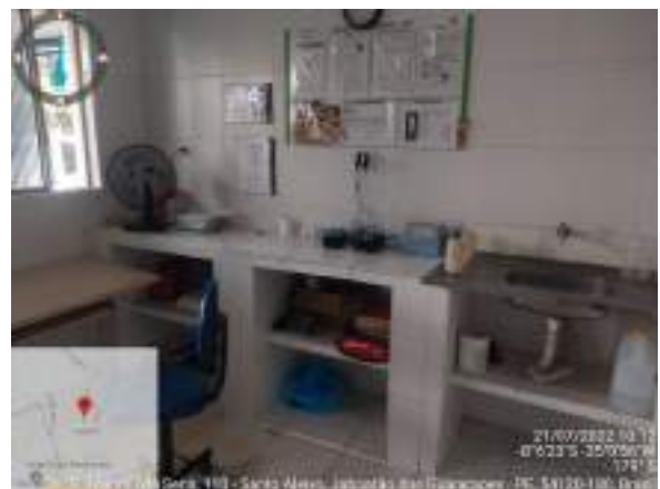
Figura 118: Laboratório de controle da ETA Manoel de Sena
