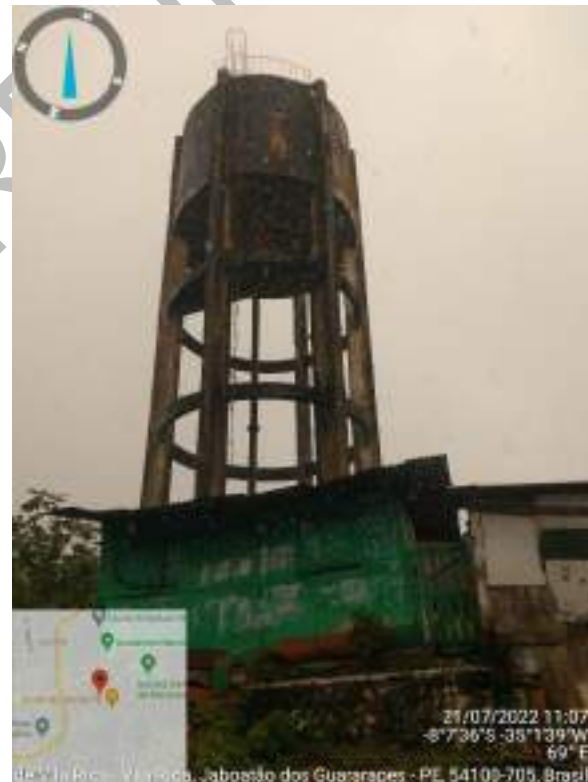
Figura 125: Reservatório elevado pertencente ao SAA de Jaboatão dos Guararapes
