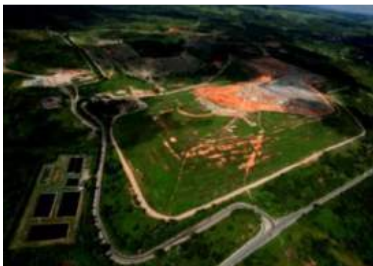
Figura 303: Vista aérea do Aterro da Muribeca no ano de 2009 (encerramento das atividades)
