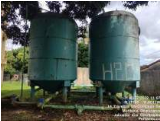
Figura 121: Filtros da ETA Muribequinha
