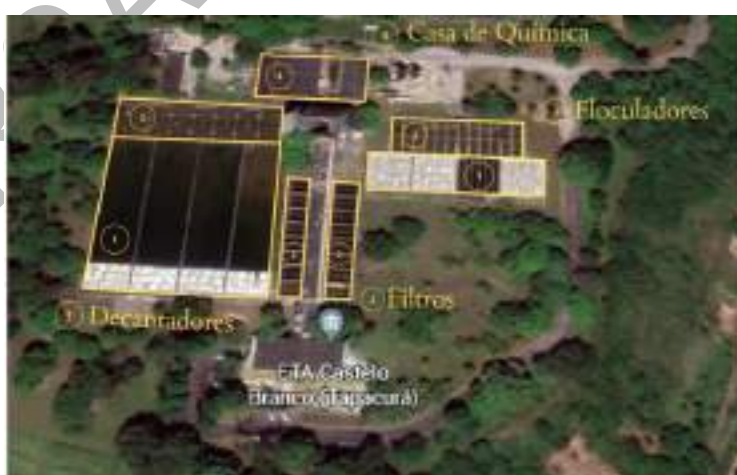
Figura 85: Vista aérea da Estação de Tratamento de Água Castelo Branco
