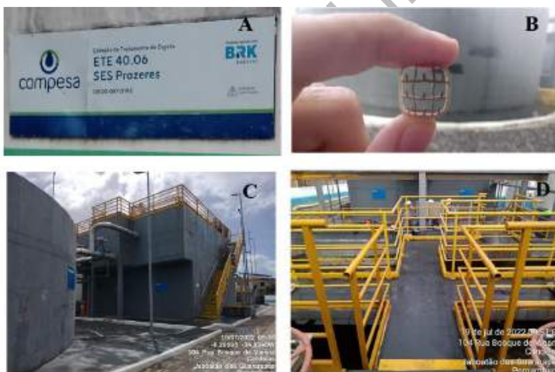
Figura 176: Detalhes da ETE Prazeres. A) placa de identificação; B) material suporte; C) filtro biológico- vista lateral; D) filtro biológico- vista superior.
