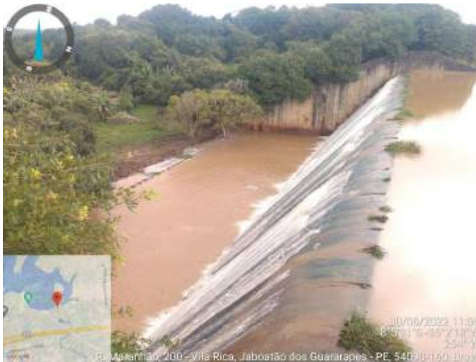
Figura 84: Vertedouro barragem de Duas Unas
