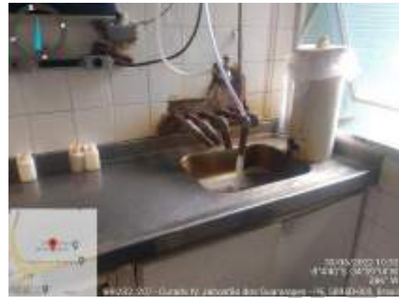
Figura 93: Laboratório de controle de qualidade da ETA Castelo Branco
