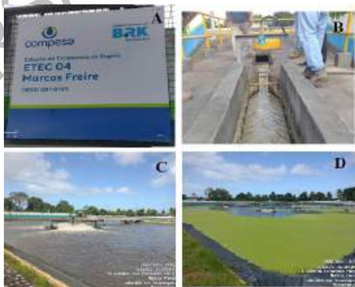
Figura 185: ETE Marcos Freire. A) Placa de identificação; B) Calha Parshall; C e D) Lagoas aeradas.
