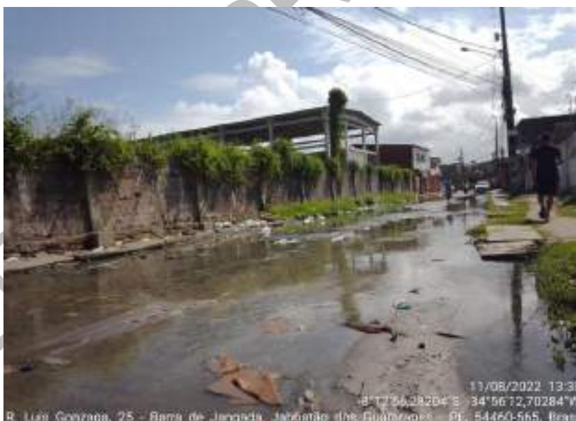
Figura 237: Trecho da rua Laguna alagada no bairro Barra de Jangada
