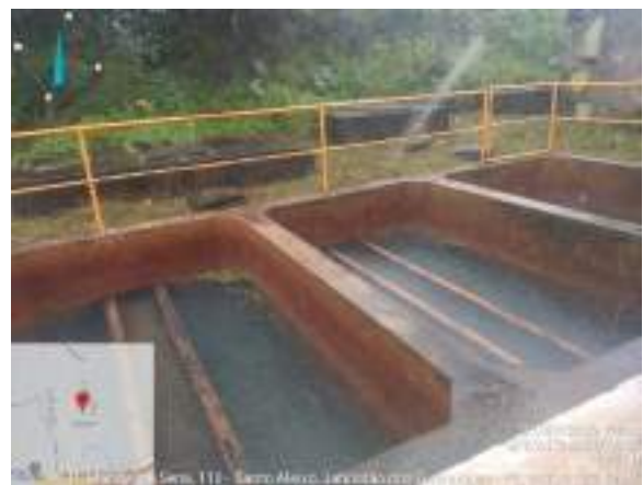
Figura 114: Filtros da ETA Manoel de Sena
