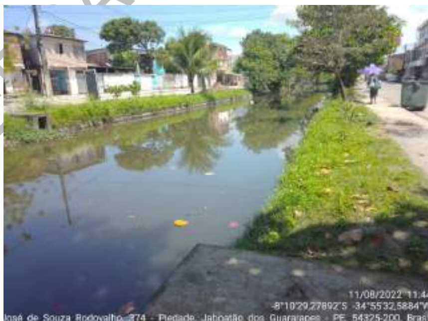
Figura 229: Trecho do Canal de Setúbal onde o nível da água está próximo do nível da rua no bairro Piedade
