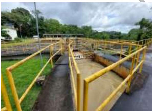
Figura 96: Vista da ETA Gurjaú
