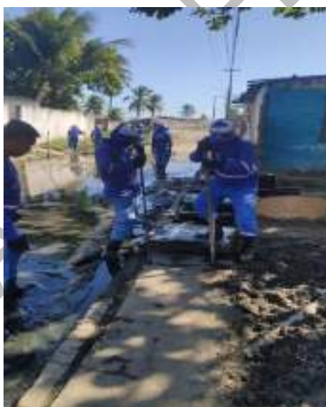
Figura 276: Varrição em canais no município de Jaboatão dos Guararapes
