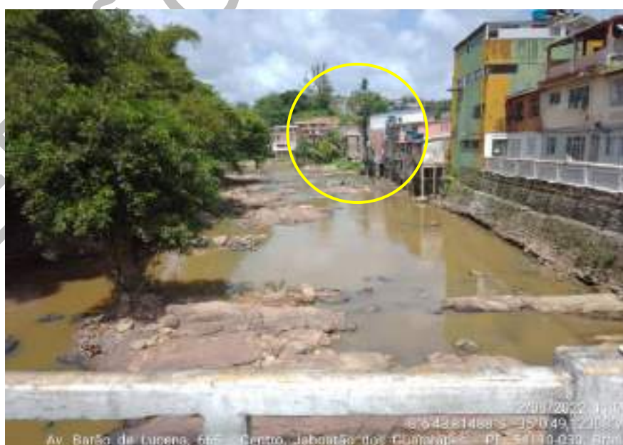
Figura 254: Identificação ligações clandestinas encontradas no Rio Duas Unas
