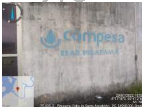
Figura 67: Estação elevatória de água bruta do Sistema Pirapama
