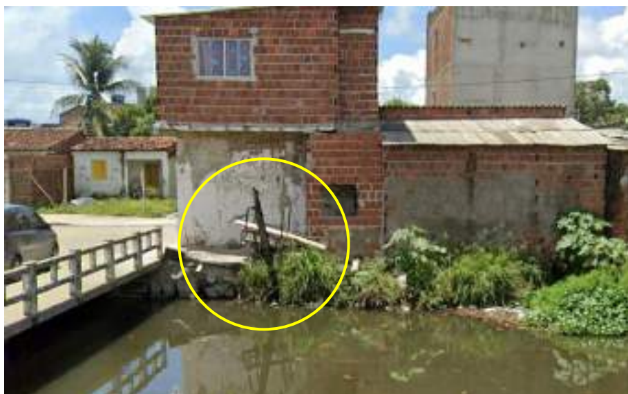
Figura 222: Detalhe das ligações clandestinas encontradas no Canal de Setúbal
