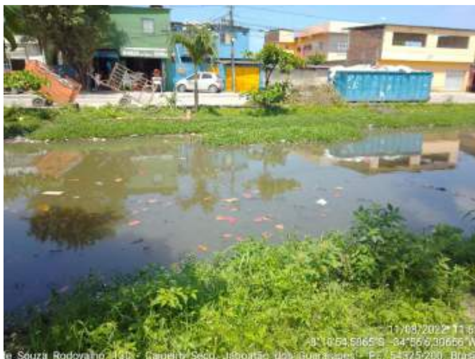
Figura 230: Trecho do Canal de Setúbal onde o nível da água está próximo do nível da rua no bairro Cajueiro Seco
