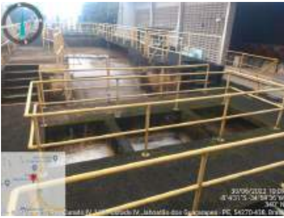
Figura 86: Vista da ETA Castelo Branco
